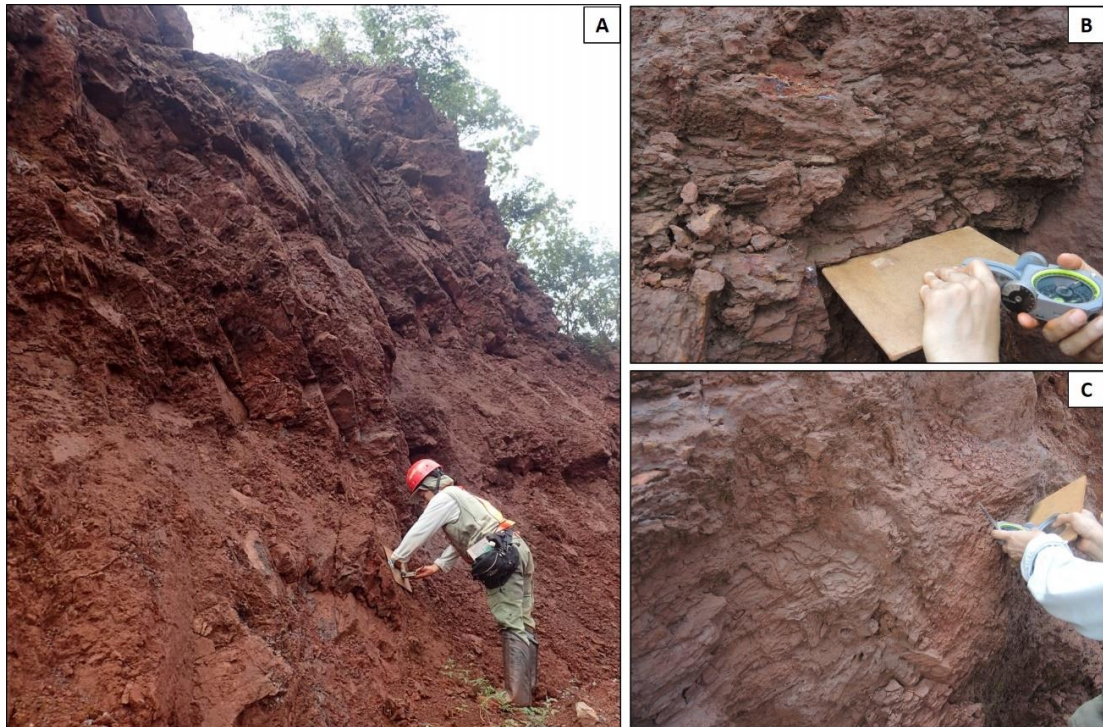
Figura 51- Padrão de estruturação das formações ferríferas. (A) Superfícies de cisalhamento; (B e C) Destaque para o bandamento e fraturas.
